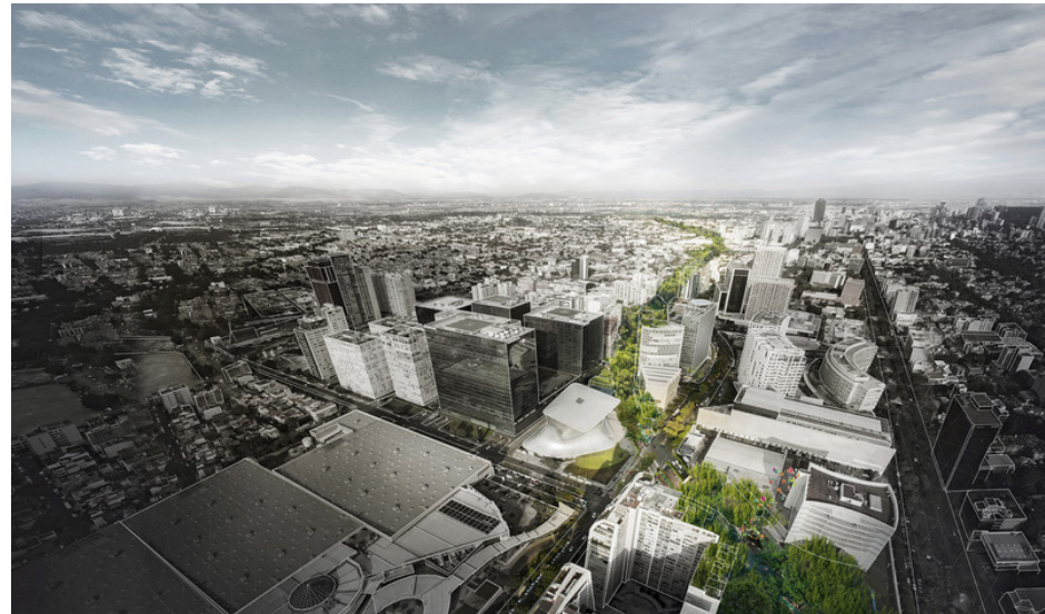
Figura 62. Vista aérea del parque lineal “Ferrocarri de Cuernavaca”. Imagen recuperada de https://capitel.humanitas.edu.mx/parque-lineal-ferrocarril-de-cuernavaca-un-espacio-para-la-integracion-ambiental-y-social/
